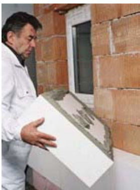
2 Einbau eines Wärmedämmverbundsystems © GPH
