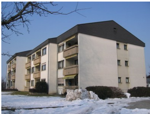
Foto: Wohnanlage Rankweil-Schleipfweg vor Sanierung
